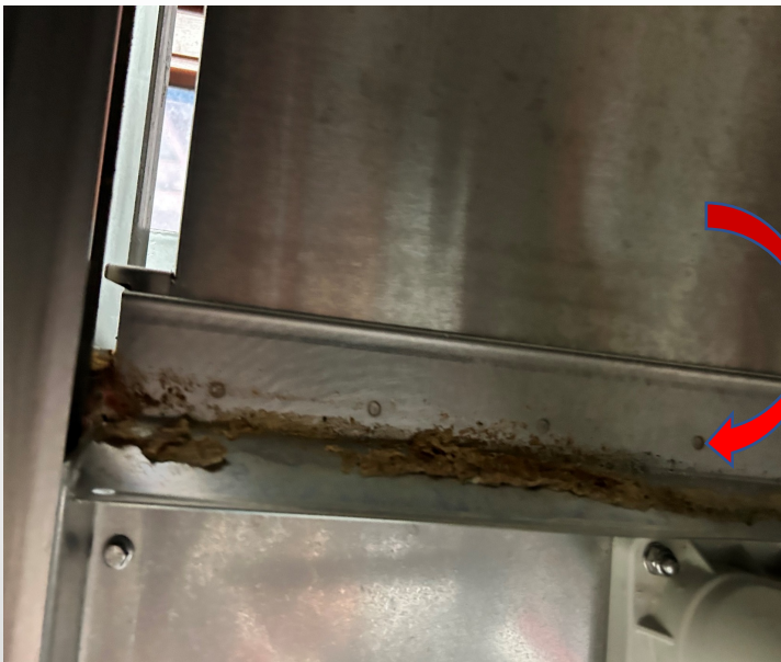
Verschmutzungen im Inneren der Haube
